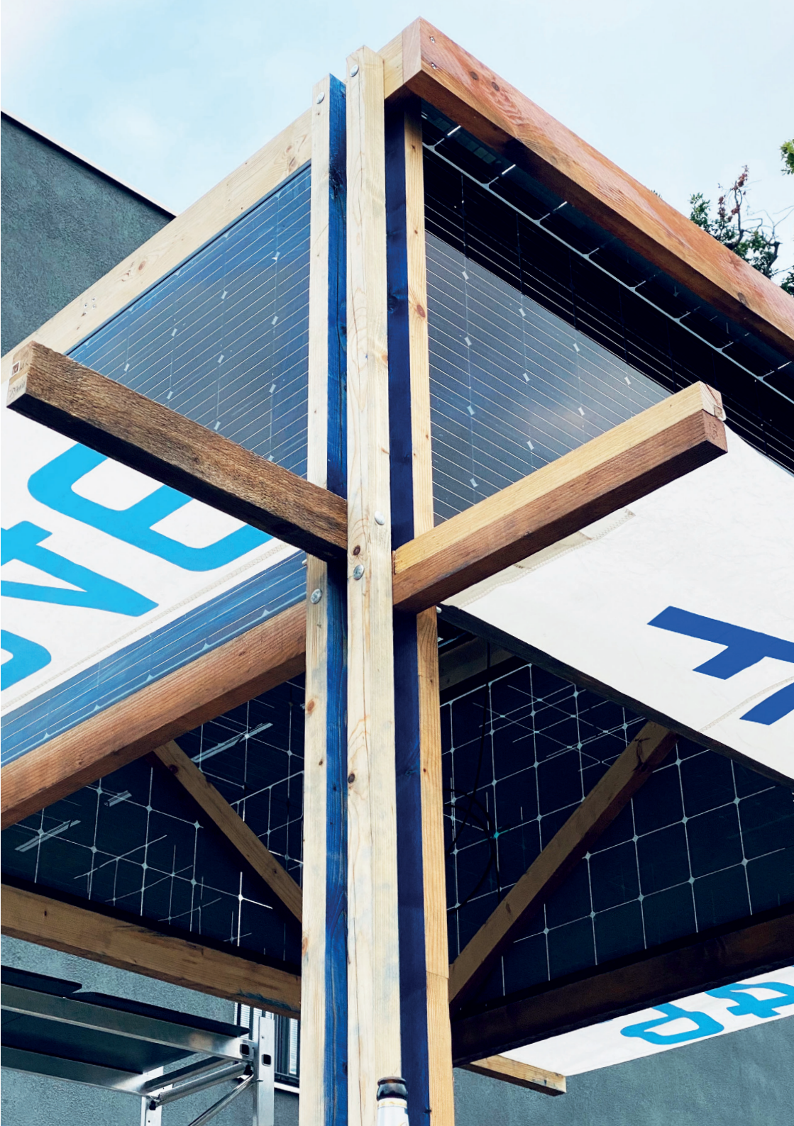
Die sechs Solarpaneele bilden das Dach des Holzpavillons
