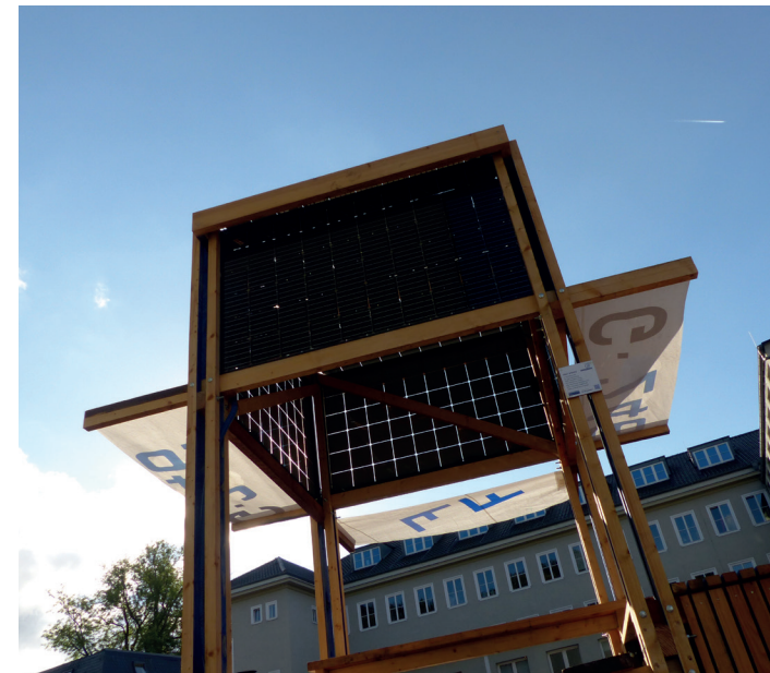
Die sechs Solarpaneele bilden das Dach des Holzpavillons
