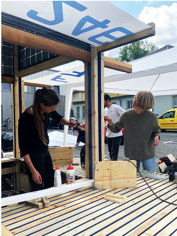
Leinöl schützt das Holz vor Witterung Linseed oil protects the wood from weathering
