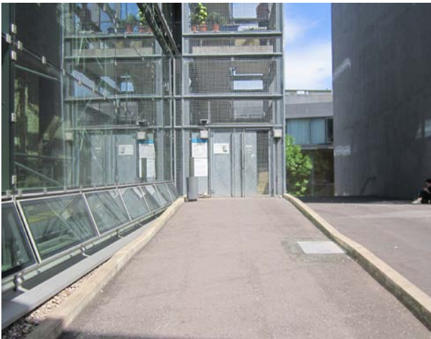
Steubenstraße 6A, barrierefreier Eingang
