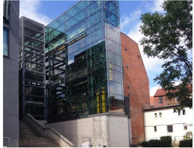
Steubenstraße 6A, Ostfassade
