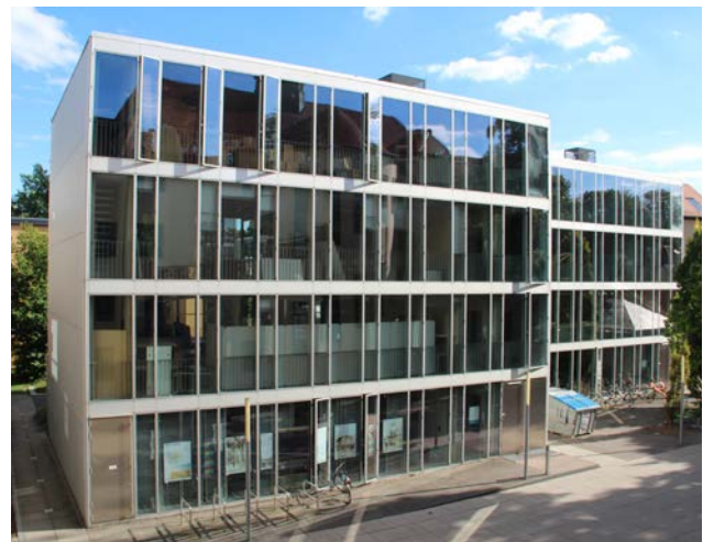
Belvederer Allee 1 a/b, Nordfassade
