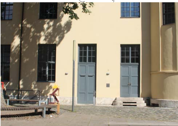
Geschwister-Scholl-Straße 8, barrierefreier Zugang Südfassade
