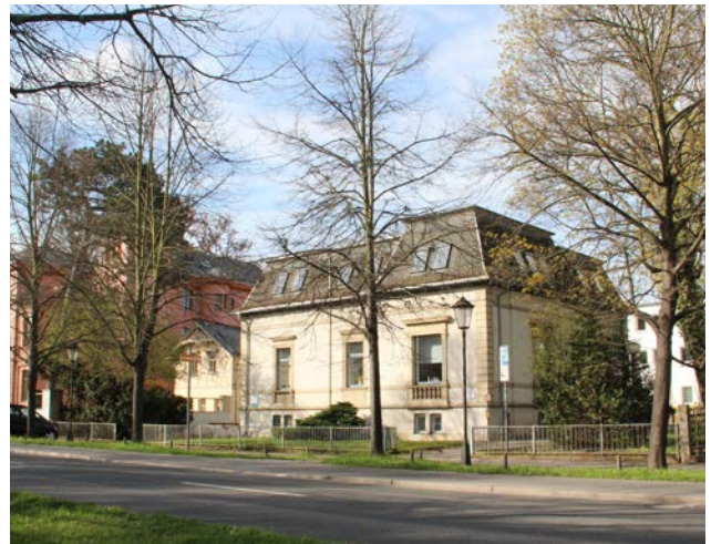
Belvederer Allee 4, Nord-Ostfassade
