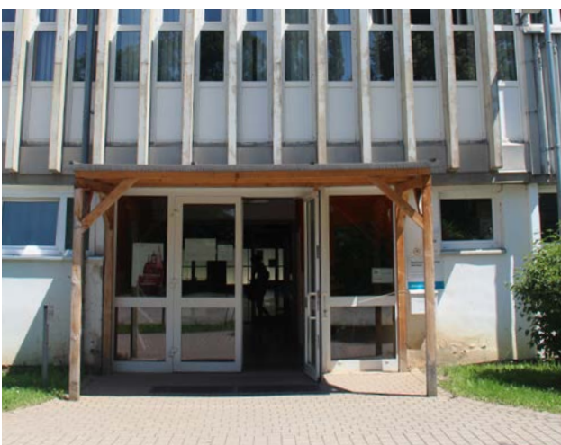
Belvederer Allee 25 a, Eingang
