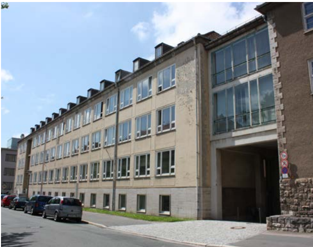
Coudraystraße 11 A, Ostfassade
