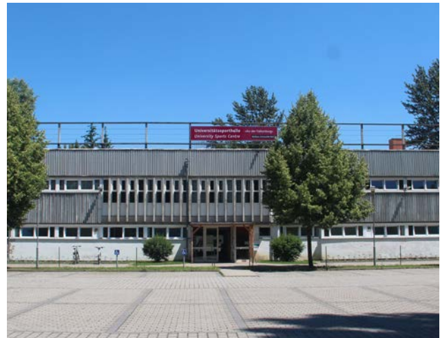
Belvederer Allee 25 a, Westfassade
